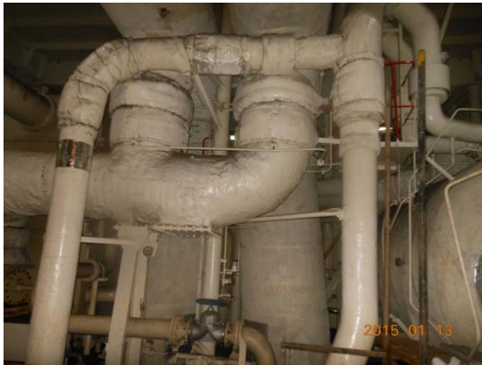
图1 管道热绝缘包覆
